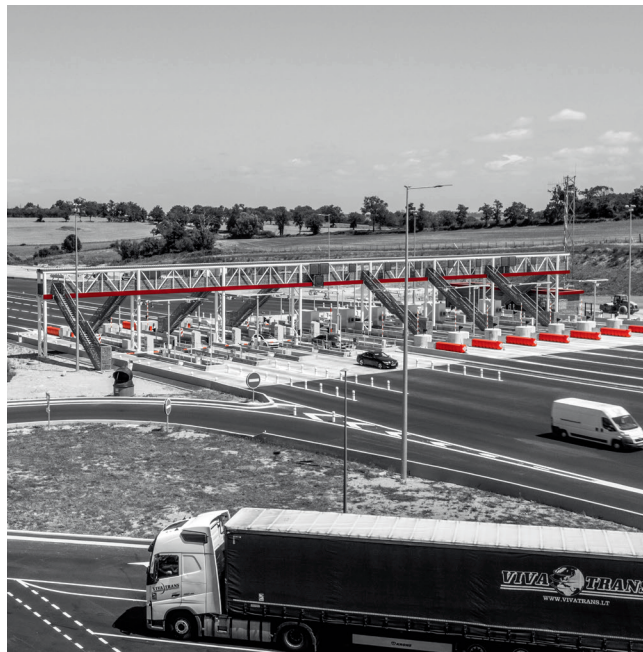
Open-Flow-Mautstation auf der A79, Digoin (Saône-et-Loire) © Eiffage
