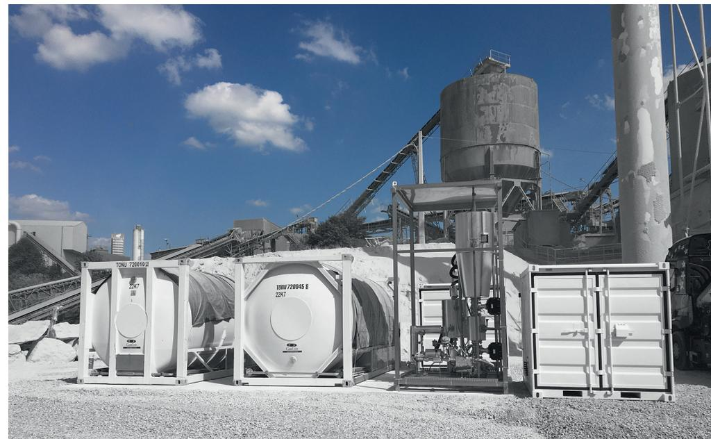
Kalkwerk mit Sitz in Bocahut (Nord). Das CO<sub>2</sub>-Auffangsystem ist das System in der Mitte des Bildes. Auf der linken Seite sind zwei CO<sub>2</sub>-Speichertanks zu sehen.
